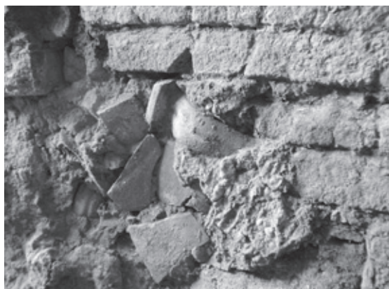
Figura 11 – Forno 1. Fragmentos de ânfora do tipo Peniche 12 encastrados na parede entre o praefurnium e a câmara de combustão.
