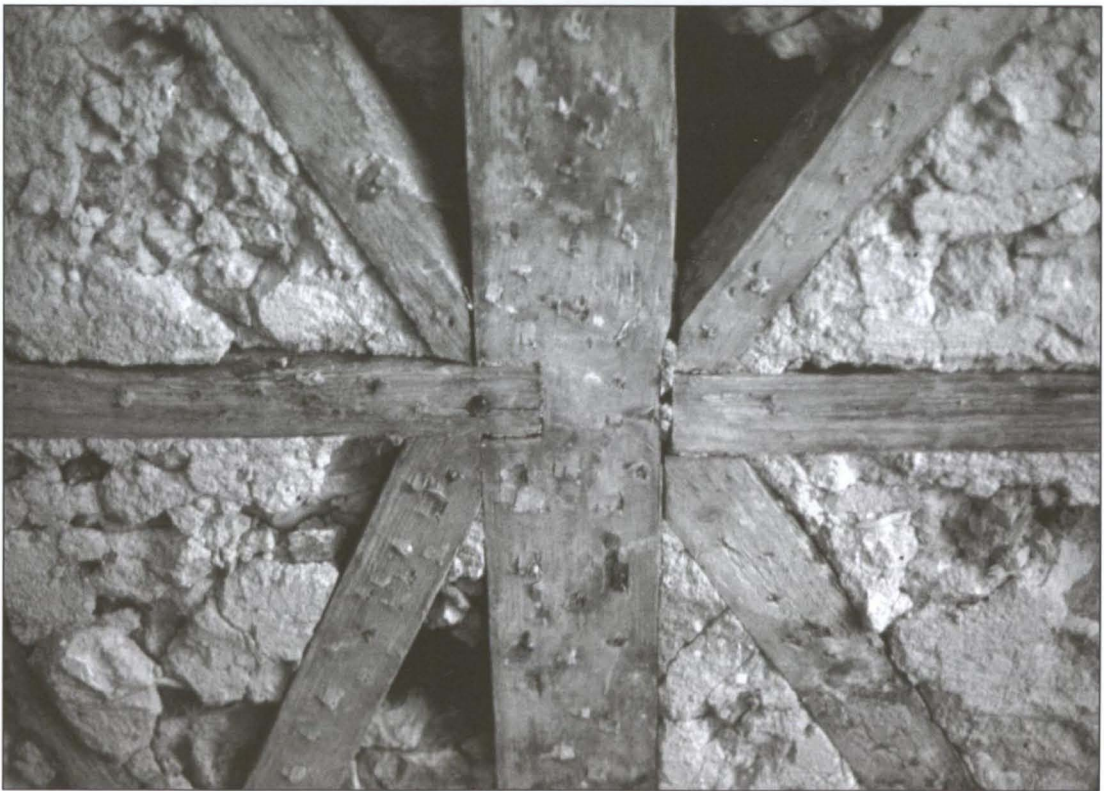
Fig. 4 – Pormenor de uma estrutura de gaiola, observada num edifício da Baixa
