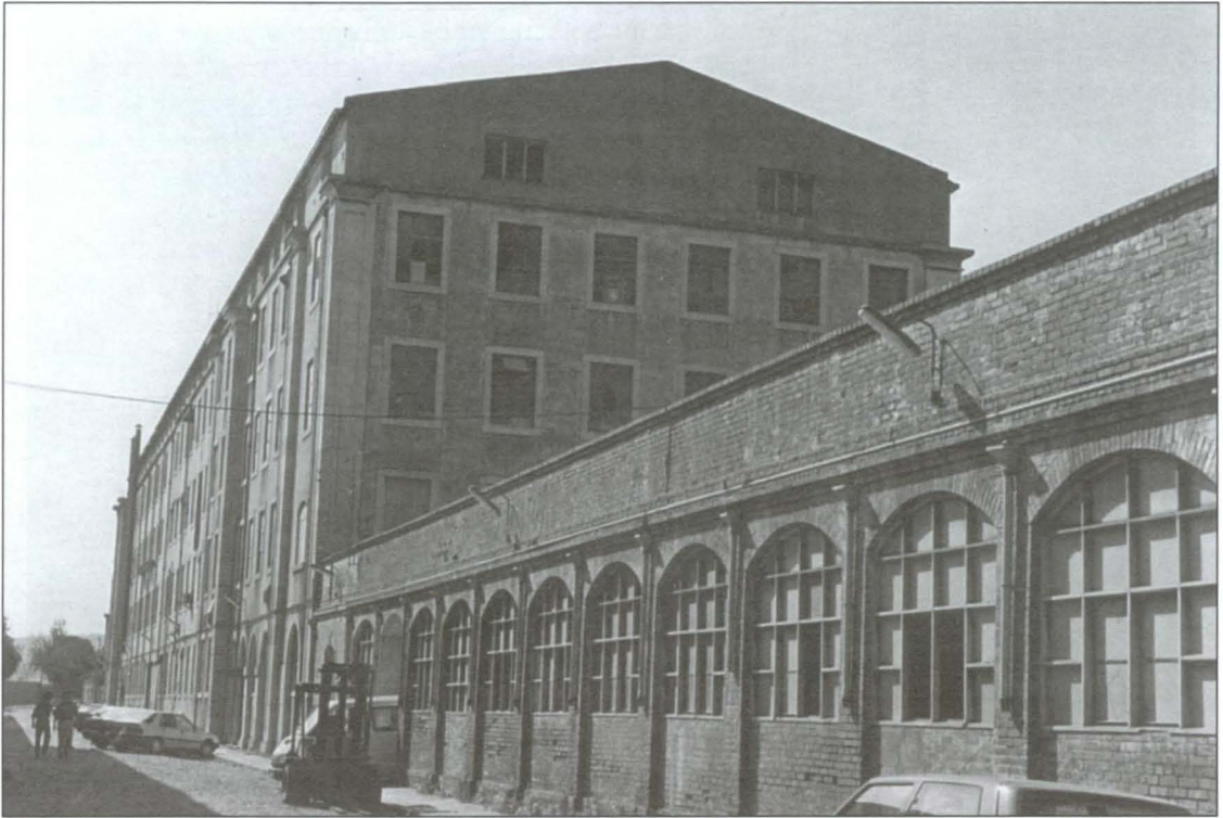
Companhia de Fiação e Tecidos Lisbonense: corpo principal e oficina de tecelagem (Foto do autor)
