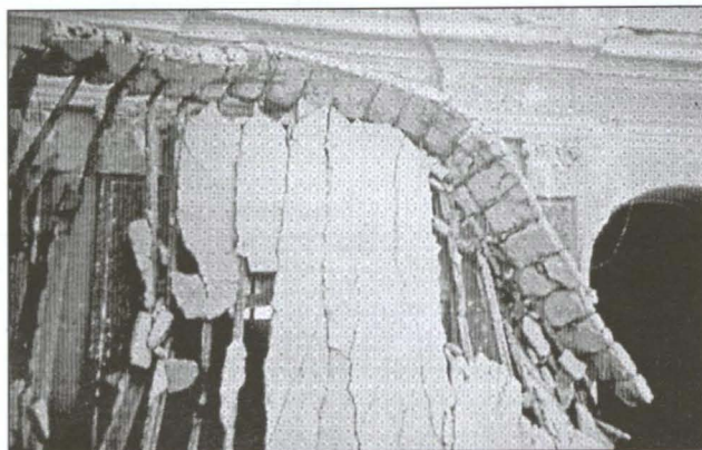
Fig. 1 – Catedral de Noto, Itália, acidente de 1996: a substituição de um piso de madeira por uma laje de betão, contribuiu para agravar os efeitos do acidente provocado pela cedência de uma coluna de alvenaria [Crocì, 1998]
