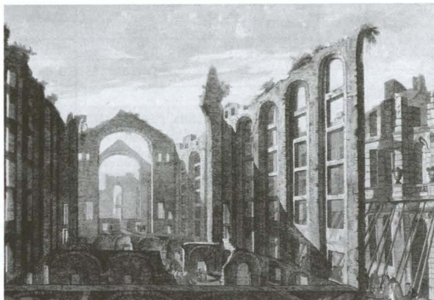
Fig. 6 – Ruínas da Casa da Ópera. Notem-se os escoramentos do lado direito
