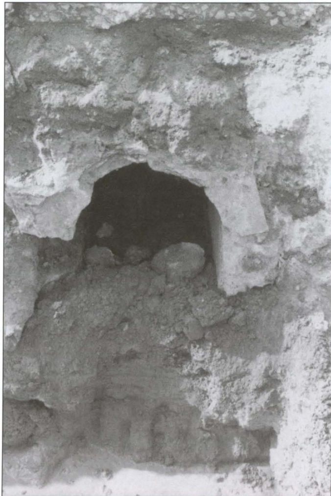
Fig. 17. Vista de Este do cano de esgoto
