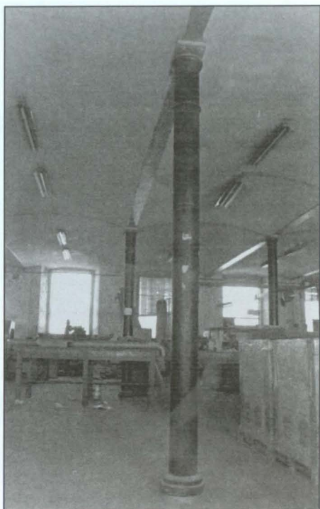
Companhia de Fiação e Tecidos Lisbonense: corpo principal, interior, coluna em ferro fundido, 4.º piso (Foto do autor)
