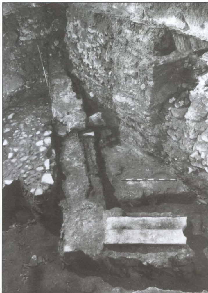
Fig. 14. Pormenor da sondagem "A" vista de Oeste. Vista lateral do esgoto pré-pombalino. São visíveis a soleira de tijolos e o reboco interno dos muretes.
