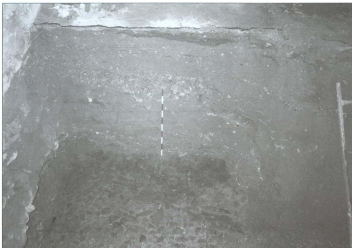
Fig. 10. – Vista tirada de Oeste do empedrado da rua pré-pombalina. A Este é visível o corte com a estratigrafia dos aterros pombalinos (camadas 1 a 6).
