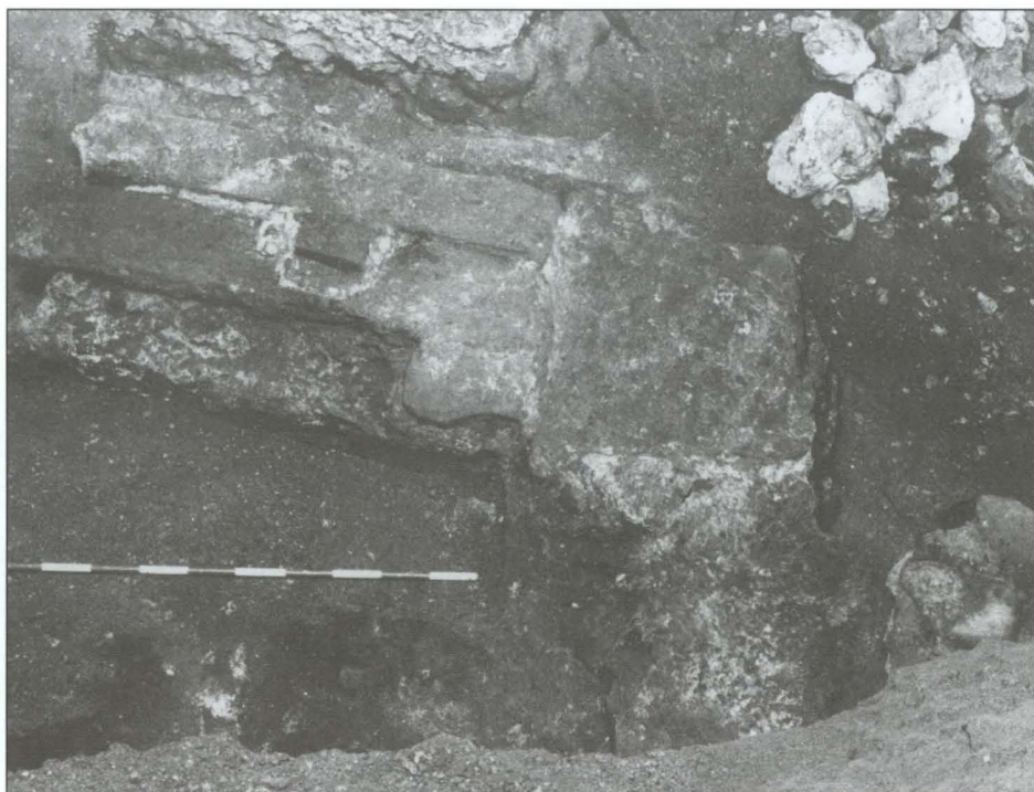
Fig. 16. – Particular tirado de Norte do edifício pré-pombalino. É visível o cunhal do edifício e a soleira da porta para o “Beco das Lajes”. O tijolo e a argamassa sobre a soleira apontam para que a porta se encontrasse entaipada.
